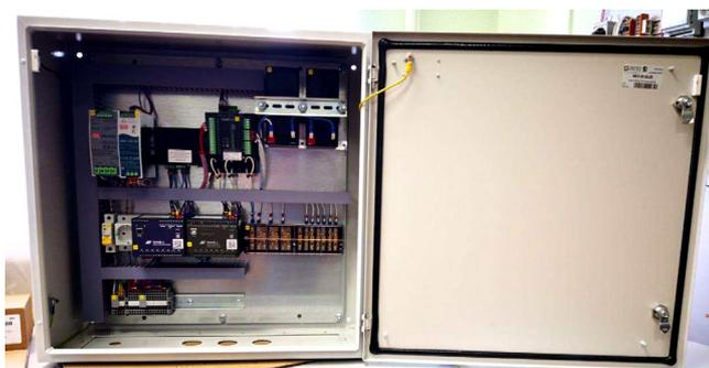
Автоматизация учета электроэнергии производится за счет подключения в ПТК ССПИ трехфазных счетчиков электрической энергии по интерфейсу RS485.
